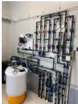
Installation de Tableau d'Eau + Pompe Doseuse avec bac mélangeur
